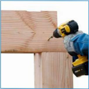
Verbinden Sie den Ringbalken mit dem Pfosten mit den Senkkopfschrauben 6 x 120 mm T30.
