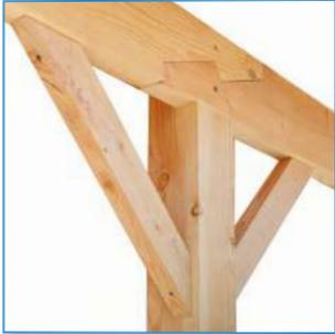
Um die Struktur wirklich zu verstärken, werden streben zwischen dem Ringbalken und den Pfosten angebracht.
