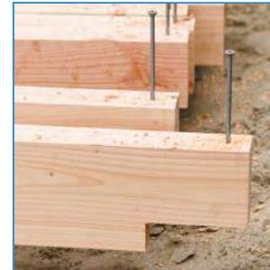
Die Querträger werden mit der Konstruktionsschraube 8 x 220 mm T40 befestigt. Der Einfachheit halber schrauben Sie sie teilweise in den Träger, bevor Sie ihn auf den Ringbalken montieren.
