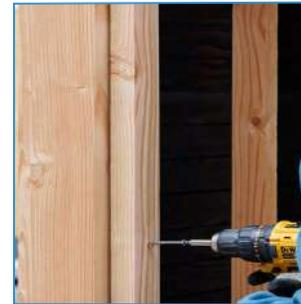
Schrauben Sie den Rahmen mit den Schrauben AR 5 x 100 mm TX25 an die Pfosten.
