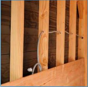
Vergewissern Sie sich bei einer doppelten Wand, dass alle elektrischen Leitungen an der gewünschten Stelle verlegt sind.
