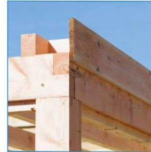
Beim Anbringen der Stirnbretter fällt die Vorderseite der Stirnbretter über die Seiten. Das erste Stirnbrett an der Seite sollte bündig mit der Vorderseite des Ringbalkens sein.
