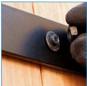
Die erste Schlossschraube kommt in das Vierkantloch, er wird von innen montiert. Die anderen Schlossschrauben werden umgekehrt montiert, d. h. der Kopf wird auf der Innenseite der Tür in das Holz geschlagen und auf der Außenseite befestigt.
