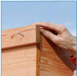
Achten Sie darauf, dass die Leiste an der Vorderseite vollständig sichtbar ist und an beiden Seiten übersteht. Die Oberseite der Leiste schließt bündig mit der Oberseite des Stirnbretts ab.
