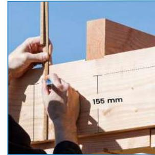
Messen Sie immer von der Unterseite des Ringbalkens 155 mm nach oben, da dies die Unterseite des Stirnbretts sein wird.
