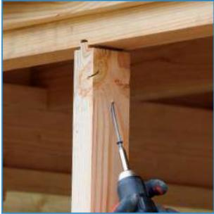
Verschrauben Sie diese schräg mit der 5 x 100 TX 25.
