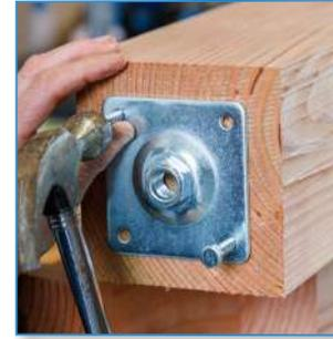
Schrauben Sie die mit dem Betonsockel mitgelieferte Justierplatte an der Unterseite des Pfostens fest. Klopfen Sie die Schrauben mit einem Hammer leicht in die Unterseite des Pfostens und ziehen Sie sie dann mit einem Schraubenschlüssel fest.
