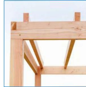
Alle Querträger können nun auf den Ringbalken montiert werden. Die Querträger, auch Pfetten genannt, haben Aussparungen für die direkte und korrekte Montage auf den Ringbalken.
