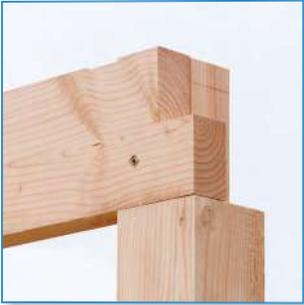
Die Ringbalken werden auf Maß geschnitten und passen perfekt zusammen. Bei Breiten über 4 m ist der Ringbalken mit ein Schräges Hakenblatt versehen.
