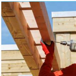
Zur Montage der Stirnbrettklotzen bohren Sie von der Trägerseite (Innenseite) vor und schrauben dann die Stirnbrettklotzen mit dem 5 x 120 mm T25 fest. Verwenden Sie 2 Schrauben pro Stirnbrettklotz.
