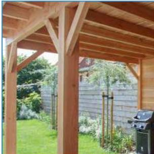
Die freistehenden Pfosten haben 2 Streben pro Pfosten. An den Seiten, an denen eine Rück- oder Seitenwand angebracht ist, brauchen Sie keine Streben zu verwenden.
