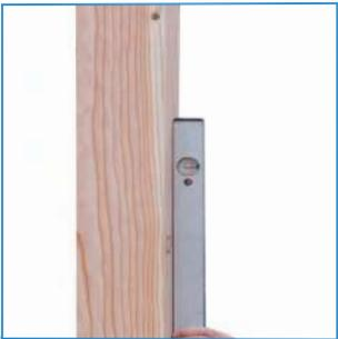
Achten Sie darauf, dass alle Pfosten beim Anschrauben der Ringbalken waagrecht stehen.
