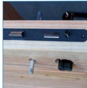
Setzen Sie das Schloss ein und führen Sie den Zylinder und die Vierkantstange durch das Schloss. Schrauben Sie das Schloss mit den mitgelieferten Schrauben fest.
