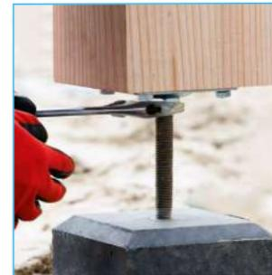
Nun können die Pfosten auf die Gewindeenden der Betonsockel gesetzt werden. Dies kann mit einem Schraubenschlüssel gemacht werden, aber Sie können auch die Pfosten runter drehen.
