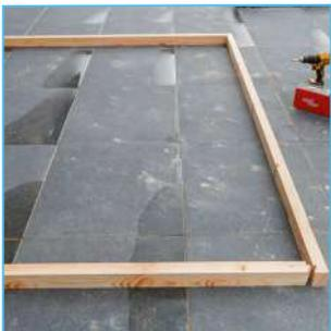
Stellen Sie auf dem Boden einen U-Rahmen aus der unteren Latte und den Seiten her, so dass er vollständig zwischen den Pfosten und dem Fundamentbalken liegt. Lassen Sie diesen Rahmen ebenfalls 3 cm nach innen fallen.
