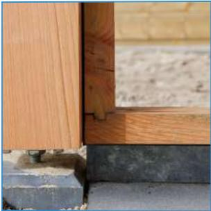
Platzieren Sie den Fundamentbalken zwischen den Betonsockel. Die Oberkante des Fundamentbalkens muss auf gleicher Höhe mit der Unterseite des Pfostens sein.
