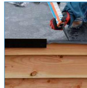
Legen Sie einen langen Streifen EPDM-Kit auf das Profil oder auf das EPDM. Immer auf der Innenseite des Daches. Drücken Sie das Profil fest auf das Dach und über die andere Seite des Verbindungsstücks. Verschrauben Sie das gesamte Profil mit 9 Schrauben. An beiden Enden und immer im Abstand von 30 Zentimetern.
