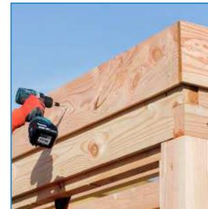
Die Stirnbretter werden mit 4 x 50 mm TX15-Schrauben befestigt, immer 2 pro Stirnbrett, jetzt aber von außen.
