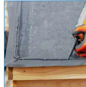
Beginnen Sie mit dem Außenecke Dachrandprofil, die mit 4 Schrauben geliefert wird. Sie können die Ecken vorbohren, etwa 10 cm von der Ecke und etwa 10 cm von beiden Enden entfernt.
