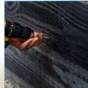
Verschrauben Sie die Keilstülp-schalungen mit 4 x 50 mm TX15.
