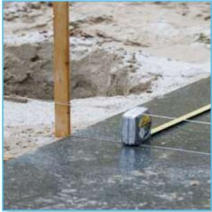
Durch Setzen von Holzpflocken mit Draht können Sie die Betonsockel sauber ausrichten. Überprüfen Sie, ob die Abstände zwischen den Betonsockel mit dem per E-Mail zugesandten Fundamentplan übereinstimmen.
