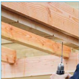
Wenn die richtige Position ermittelt wurde, kann die oberste Latte mit dem 5 x 100 mm TX 25 Schrauben verschraubt werden.
