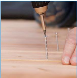
Die Stülpchalungsplanken werden mit 4 x 45 mm TX 20 Schrauben an jeden Balken geschraubt. Achten Sie darauf, dass die Schrauben im Holz versenkt sind.
