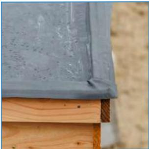
Dann können Sie den Rest EPDM, die über das Dach hängt, wegschneiden. Lassen Sie das EPDM noch 1 cm überstehen.
