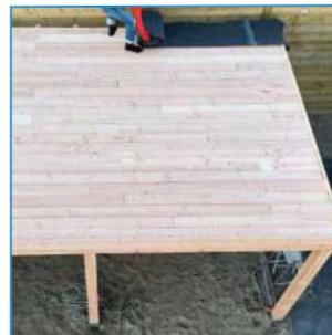
Stellen Sie sicher, dass das Dach sauber und trocken ist. Rollen Sie das EPDM aus und lassen Sie sie auf allen Seiten über den Dach Rand fallen. Lassen Sie das EPDM eine halbe Stunde lang ruhen.
