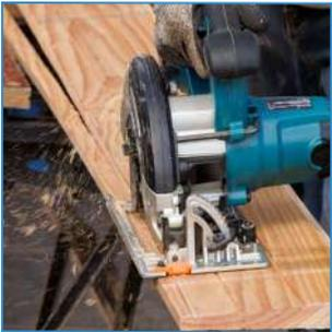
Für den letzten (oberen) Keilstülp-schalung messen Sie den Abstand und sägen Sie einen Teil des Brettes in Längsrichtung ab, damit er gut passt.
