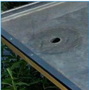
Ziehen Sie mit EPDM-Kit 3 Kreise in den Bereich, in dem die Runde Klappe des Wasserablaufs platziert werden soll. Einen in der Nähe der Ausparung, einen in der Mitte und einen am äußeren Rand. Dadurch wird der Kit gut verteilt und es kann keine undichte Stelle entstehen. Nun mit einem Roller andrücken.
