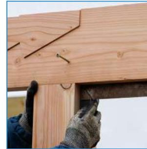
Die Hakenblattverbindung passt perfekt zusammen. Für die Verschraubung der Hakenblattverbindung siehe die Zeichnung unten. Schrauben Sie sie gemäß dem grünen Bild.
