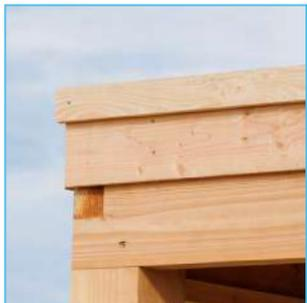
Links und rechts fällt das Ende der seitlichen Leiste hinter die vordere Leiste zurück (genau wie bei den Stirnbrettern). Schrauben Sie die Zierleisten mit dem 3,5 x 30 mm TX 15 fest.
