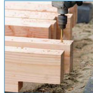
Bohren Sie alle Querträger mit einem 6-mm-Bohrer vor.
