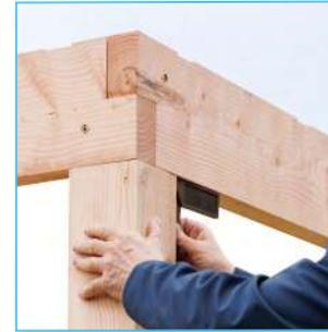
Achten Sie beim Verschrauben der Ringbalken mit jedem Pfosten darauf, dass die Ecken rechtwinklig sind.
