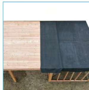
Sprühen Sie einen Streifen EPDM-Kit von etwa 60 cm auf das Dach und dann auf das EPDM. Warten Sie, bis es gerade noch so klebt, rollen Sie das EPDM sauber über den eingespritzten Abschnitt und drücken Sie es gut an, zum Beispiel mit einem weichen Besen oder einen Farbroller.
