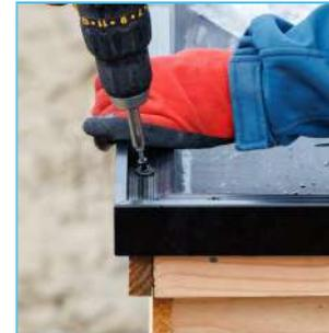
Es ist wichtig, dass Sie einen halben Zentimeter von der Innenseite der Dachkante entfernt eine Schicht aus EPDM-Kit auftragen. Dies verhindert Leckagen, auch wenn der Regen bei starkem Wind in die Profile läuft (Wasserschlag).
