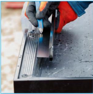
Zum Verbinden der Dachrandprofile und Ecken-Dachrandprofile verwenden Sie das Verbindungsstück. Stecken Sie dazu die Hälfte des Verbindungsstücks in das Ecken-Dachrandprofil, bis es nicht mehr weiter kann.
