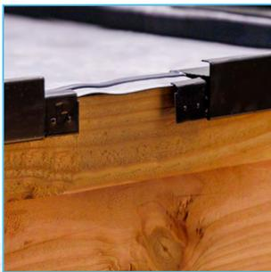
Warten Sie mit dem Verschrauben der letzten 2 Ecken, bis die letzten Verbindungsstücke in die Dachrandprofile geschoben worden sind. Die Dachrandprofile und/oder das Ecken-Dachrandprofil müssen leicht angehoben werden, sonst können Sie die Dachrandprofile nicht über das Verbindungsstück schieben. Dann schrauben Sie alles komplett fest!
