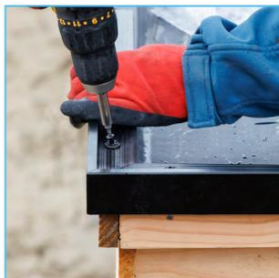
Fangen Sie an einer der Ecken mit einem Ecken-Dachrandprofil an. Das Ecken-Dachrandprofil wird mit 4 Schrauben geliefert. Sie können die Ecken-Dachrandprofile vorbohren, etwa 10 cm von der Ecke und etwa 10 cm von beiden Enden entfernt.
