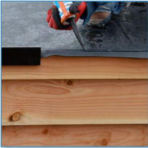
Tragen Sie dann einen langen Streifen EPDM-Kit auf die EPDM-Dachfolie auf; Immer auf der Innenseite der Dachkante. Drücken Sie das Dachrandprofil ganz fest auf die Dachkante und über die andere Seite des Verbindungsstücks. Pro Dachrandprofil mit einer Länge von 250 cm sind 9 Schrauben zu verwenden, an beiden Enden auf 10 cm und alle 30 Zentimeter.
