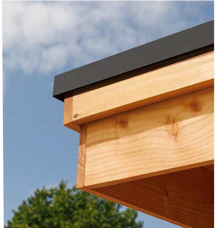
*Mit Dachrandprofilen können Sie das Dach gegen Witterungseinflüsse schützen und vorbeugen, dass ungeziefer in die Kanten eindringen.*
