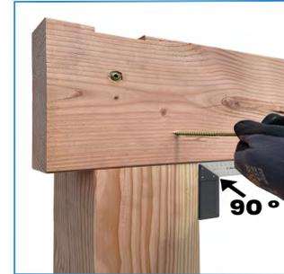
Befestigen Sie den Querträger an den Pfosten und Achten Sie darauf, dass die Verbindung zwischen Pfosten und Querträger rechtwinklig ist. Verwenden Sie 2 Senkkopfschrauben pro Außenpfosten. Haben Sie mehr als 2 Pfosten und ist es für Sie günstiger, den mittleren Pfosten (max. 70 cm) außerhalb der Mitte zu positionieren? Dann können Sie dieselben Schrauben verwenden, um die Hakenblattverbindung von oben und unten zu befestigen.
