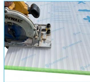
Wenn Sie Ihre Stegplatten in der Breite und/oder Länge zuschneiden müssen, sollten Sie dies zuerst tun (d. h. bevor Sie die Folie entfernen). Bitte lesen Sie vor dem Sägen diese Anleitung vollständig durch! Bitte beachten Sie, dass Sie das Aluminium-U-Abschlussprofil zur Länge des Panels hinzufügen müssen.
