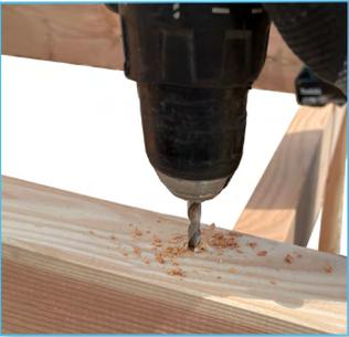
Wenn Sie die Träger am Querträger befestigen, sollten die Löcher vorgebohrt werden. Achten Sie darauf, dass der Bohrer in der Mitte des Querträgers endet, d. h. nicht durch Bohren.
