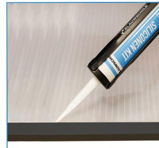
Oben, in der Nähe der Alu-U-Abschlussprofile, tragen Sie bitte eine dünne Schicht Silikon Kit auf. Dadurch wird verhindert, dass vom Dach ablaufendes Wasser an der Kante stehen bleibt.
