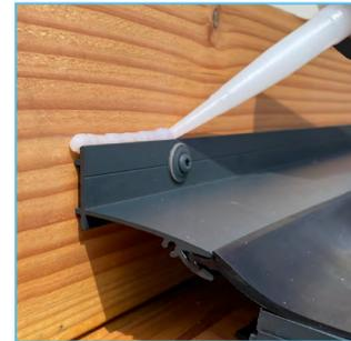
Drücken Sie nun die Gummilasche in das Wandprofil. Anschließend dichten Sie die Fuge zwischen Wandprofil und Wand mit dem mitgelieferten Silikonen Kit ab.
