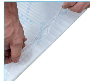
Entfernen Sie nun die Schutzfolie an der vorderen und hinteren Seite ca. 10 cm umlaufend entlang aller Kanten der Stegplatte. Entfernen Sie noch nicht die gesamte Folie. Dies verhindert Beschädigungen beim Einbau. Auf diese Weise wissen Sie immer, was die Oberseite der Polycarbonat Stegplatte ist (die bedruckte Seite).
