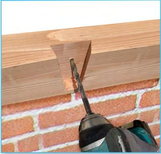
Montieren Sie den Wandbalken (den Holzbalken mit gefrästen Schwalbenschwanzverbindungen) in der richtigen Höhe waagrecht an der Wand. Bohren Sie in der Mitte der eingefrästen Schwalbenschwänze ein Loch bis in die dahinter liegende Wand und ziehen Sie die mitgelieferten Maueranker fest. Berücksichtigen Sie dabei das noch zu montierende Wandprofil. Über dem Wandbalken ist ein Abstand von 50 mm freizuhalten.
