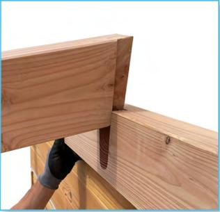
Sie können nun damit beginnen, die Querbalken in den Schwalbenschwanzverbindungen der Wandbalken zu befestigen. Alle Balken sind bündig zueinander. Senken Sie den Balken vorsichtig in die Fuge, so dass er in der gefrästen Aussparung des Querbalkens liegt. Zum Schluss können Sie den Balken mit einem Gummihammer in der Schwalbenschwanzverbindung "hämmern". Es kann sein, dass der Balken nicht ganz in den Wandbalken passt. Das ist kein Problem, das legt sich von selbst.
