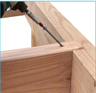
Anschließend verschrauben Sie die Träger mit den 120 x 6 mm AR-Schrauben mit dem Wandbalken.
