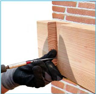
Wenn Sie den Wandbalken auf Holz montieren, verwenden Sie die mitgelieferten 6 x 120 mm AR-Schrauben.
