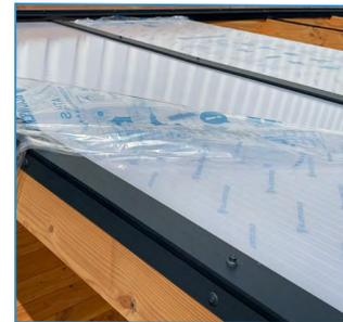
Legen Sie nun das nächste obere Profil über die beiden Stegplatten und schrauben Sie es mit den Holzschrauben fest. Die Schrauben kommen zwischen die 2 Stegplatten. Sie schrauben also nicht in die Stegplatten selbst! Achten Sie darauf, dass das obere Profil an der Vorderseite genau mit dem Alu-U-Profil bündig ist. Wiederholen Sie diese Schritte bis zum letzten Obere Profil auf das F-Profil.
