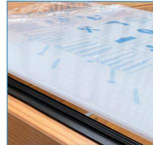
Legen Sie die erste Stegplatte mit Aluminium-U-Profil(en) auf die Konstruktion. Die vorgebohrten Löcher im Alu-U-Abschlussprofil befinden sich am Ende an der Unterseite der Stegplatte. Die bedruckte Folie auf der Stegplatte befindet sich oben. Unten steht die Stegplatte mindestens 3 cm über die Konstruktion hinaus. Entlang der Kante des Balkens lassen Sie einen Streifen von etwa 4 cm Holz frei. Die Platte liegt hier also auf einem halben Streifen Gummiauflage.
