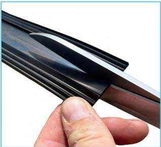
Befestigen Sie nur einen halben Streifen der Gummiauflage am ersten und letzten Träger. Schneiden Sie diesen zunächst mit einem Teppich-Messer oder einer Schere in der Mitte durch. So erhalten Sie zwei schmale Streifen von 3 cm.
