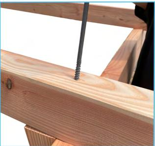
Schrauben Sie nun die Träger mit den 220 x 8 mm AR-Schrauben an den Querbalken.
